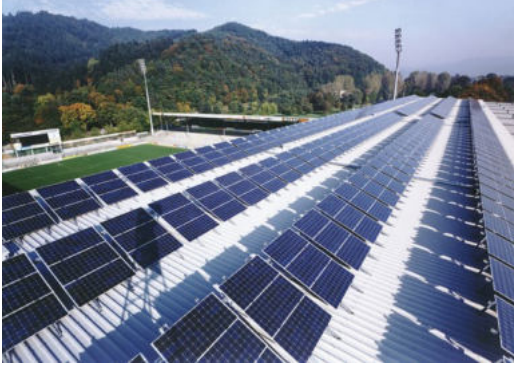
Stadion SC Freiburg
