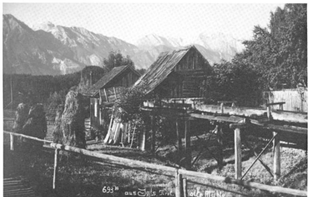
Die alte Iglter Hammerschmiede mit Rinnwerk am Ramsbach unterhalb der Eichlerstraße. (Sammlung Hannes Hundegger, Igls)
