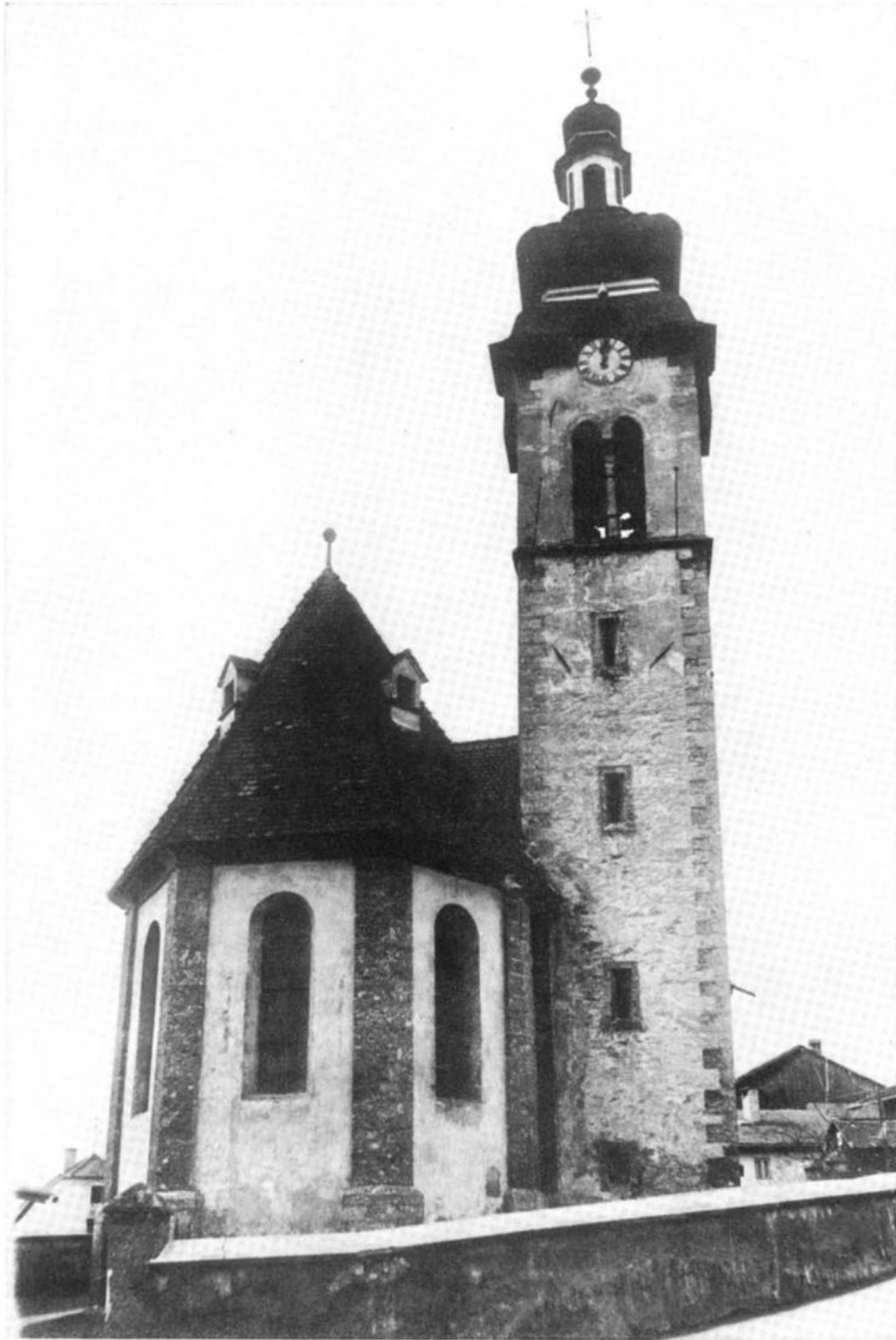
Die Pfarrkirche von Arzl „zum hl. Johannes dem Täufer“. Gotischer Bau des 15. Jh.s, Weihe 1480, welcher nach dem Brand von Arzl im Jahre 1756 durch Franz de Paula Penz eine barocke Turmhaube und im Kircheninneren Barockstukkaturen erhielt. Im Jahre 1965 wurde eine Innenrestaurierung durchgeführt. (Photo: M. Hye)
